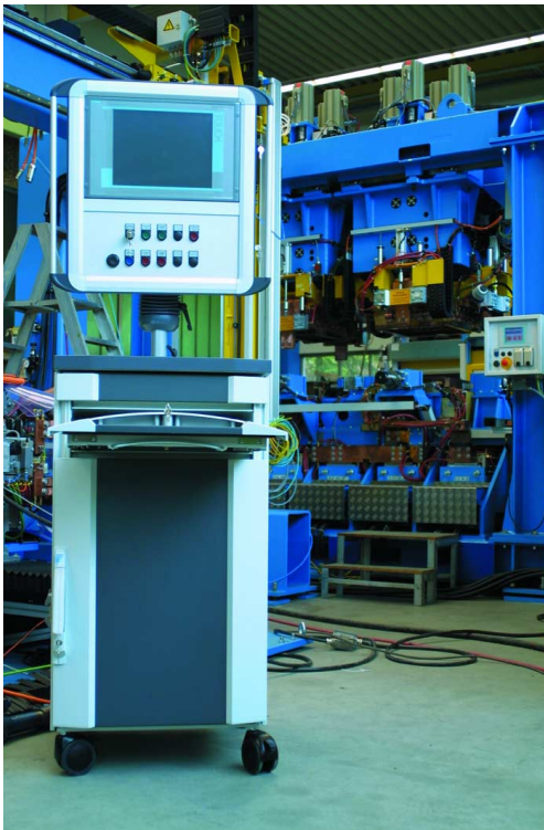
Bild 4. Die Bereichszentrale ist als IW-Station mit „Comfort Panel“ ausgeführt. Hintergrund: Buckel-schweißportal
